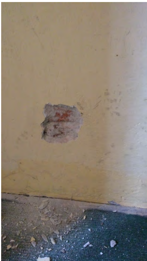
Odkrywka w ścianie nośnej
